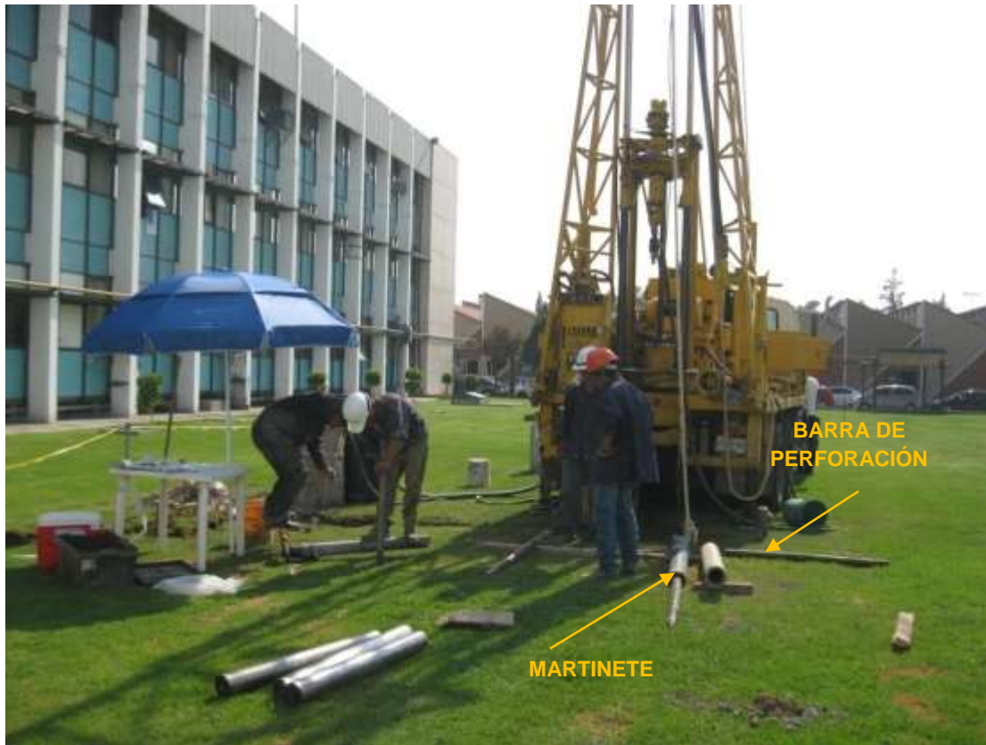
FIGURA 10.- EQUIPO DE PERFORACIÓN
